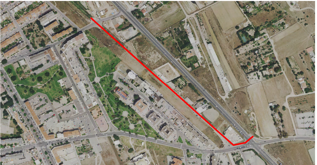
Figura 6: tratto di canale tombato presso il Rio Is Cungias
